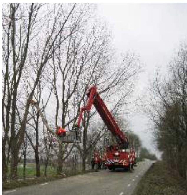
Het laatste loodje met de hoogwerker.
