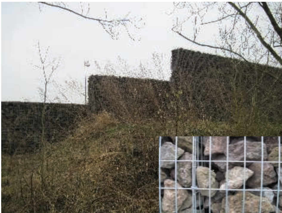
De geluidswal en in de rechterhoek de losse structuur van de wal.
