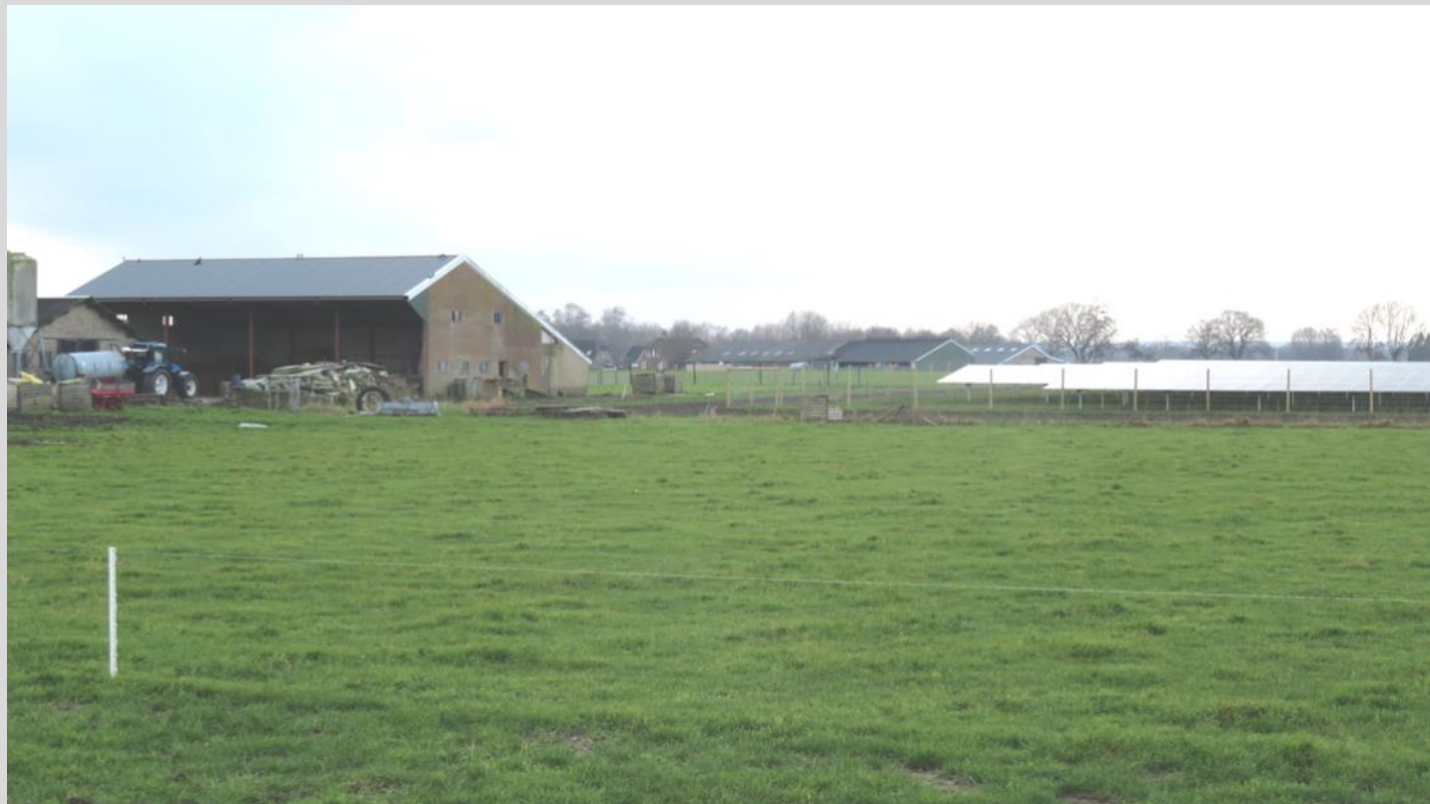
Oprukkende zonnepanelen in Broekland
