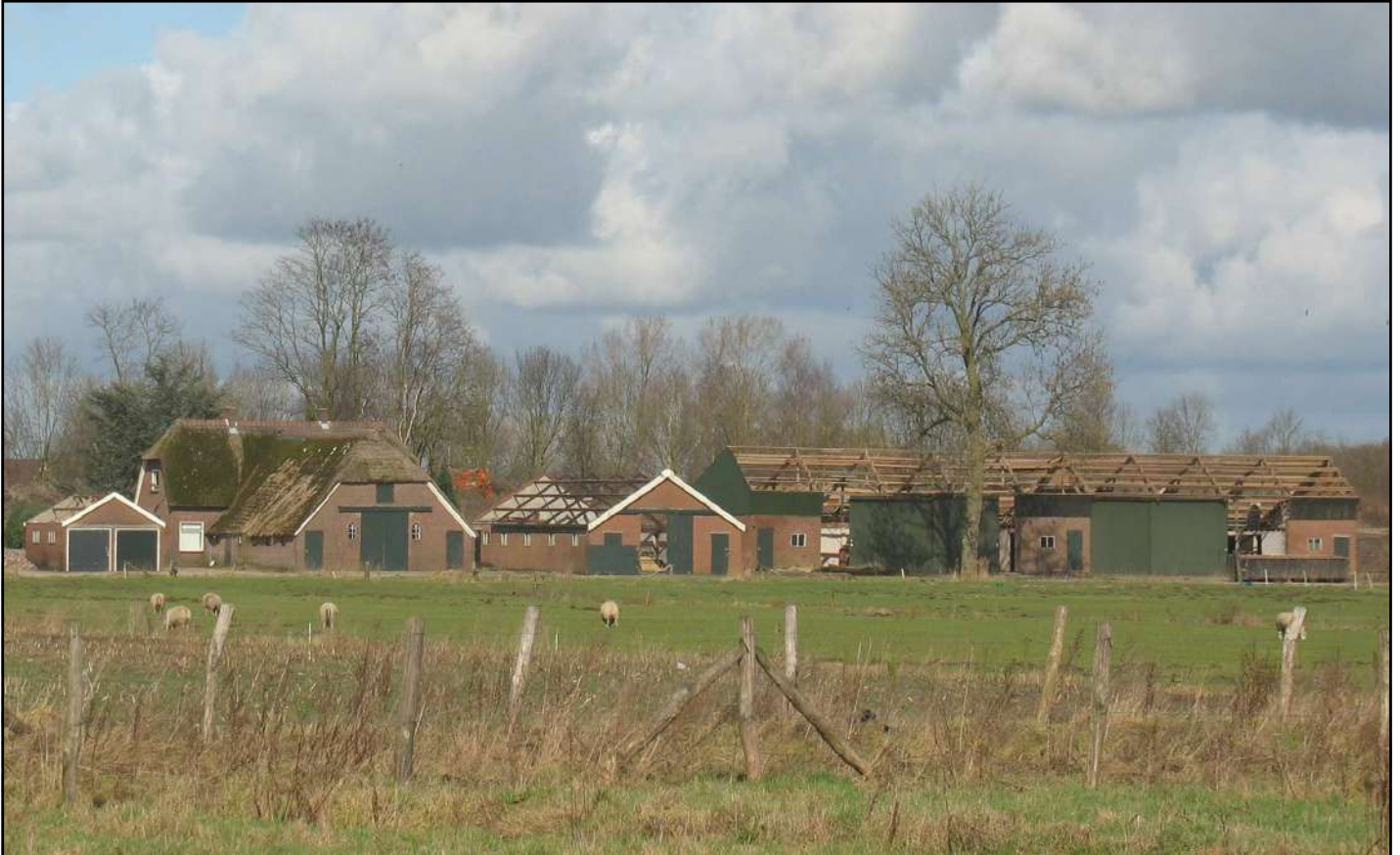
Afgebroken boerderij aan de voormalige Vellertdijk in Zuidbroek
