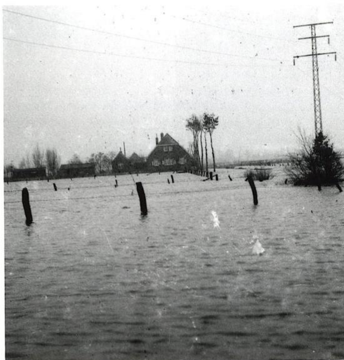
1953 Wateroverlast. Zicht op Bouwmeester
